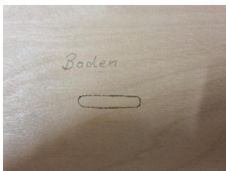
Foto 51: Die Position der Öffnung wurde auf das Bauteil übertragen
